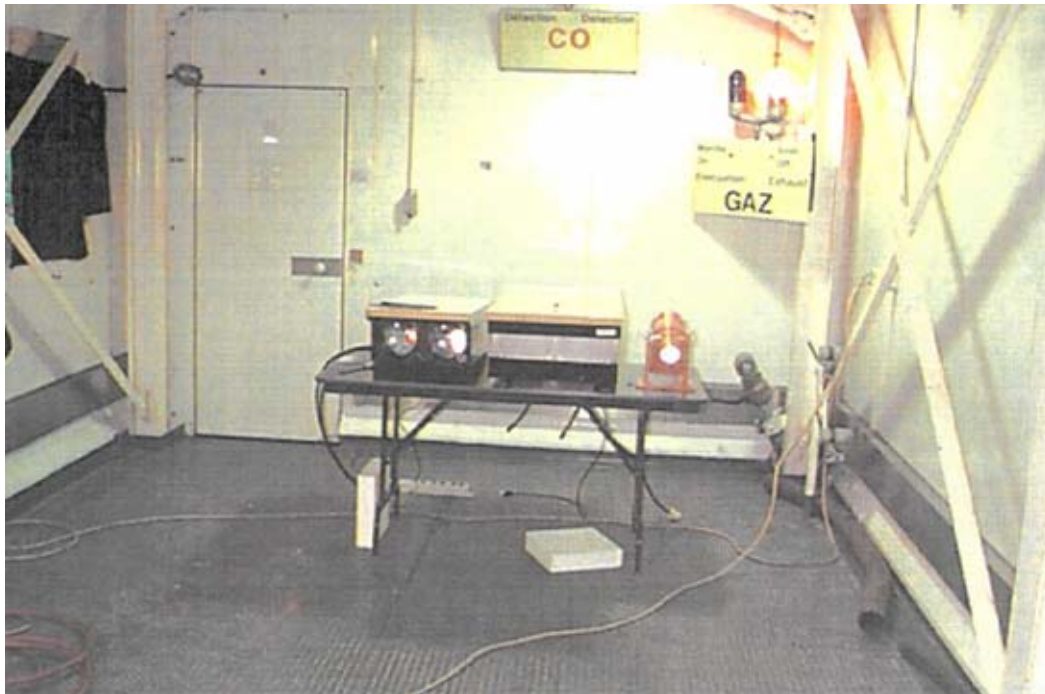
8. Installation d'un PAPI
