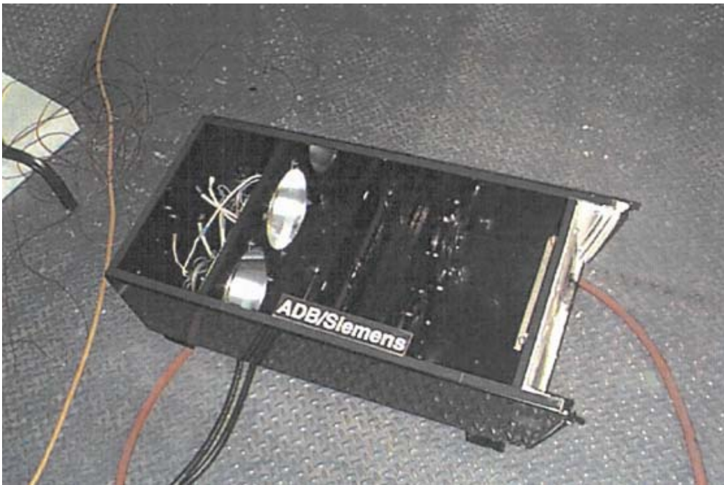
2. Vue intérieure du PAPI ADB/Siemens.
