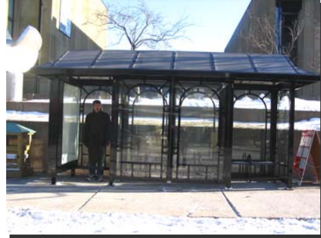
Le premier des 11 abribus qui seront installés en 2007.
