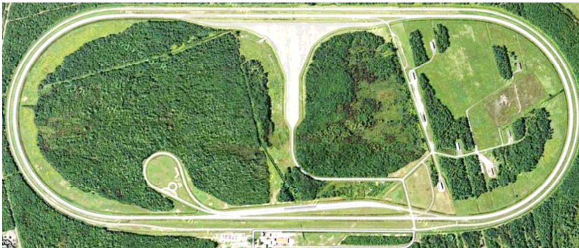
Figure 3 : Vue aérienne de la piste d'essais dynamiques de Blainville (Québec)
